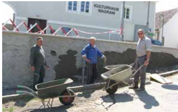
Die Brustmauer unmittelbar neben dem Wagrainer Milchhaus wurde ebenfalls saniert. Ein Teil der Mauer musste abgetragen und neu betoniert werden. Bei den Arbeiten haben mehrere freiwillige Helfer mitangepackt und einen wesentlichen Beitrag zur Sanierung beigetragen. Im Bild (v. l.) Georg Jorg sen., Gerhard Lechner und Rudolf Huber.
