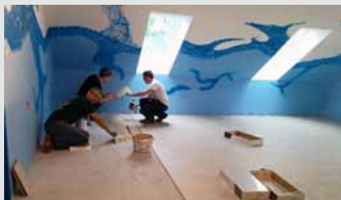
Blick auf die Baustelle: neuer Probenraum „fluente“ im Obergeschoß.
