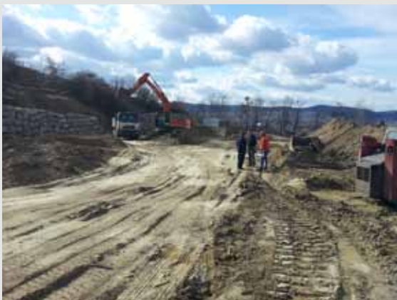
Mit den Erdarbeiten wurde im Tobel bereits begonnen.
