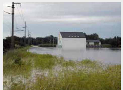
Hochwasser im Jahr 2006, Blickrichtung DLZ.
