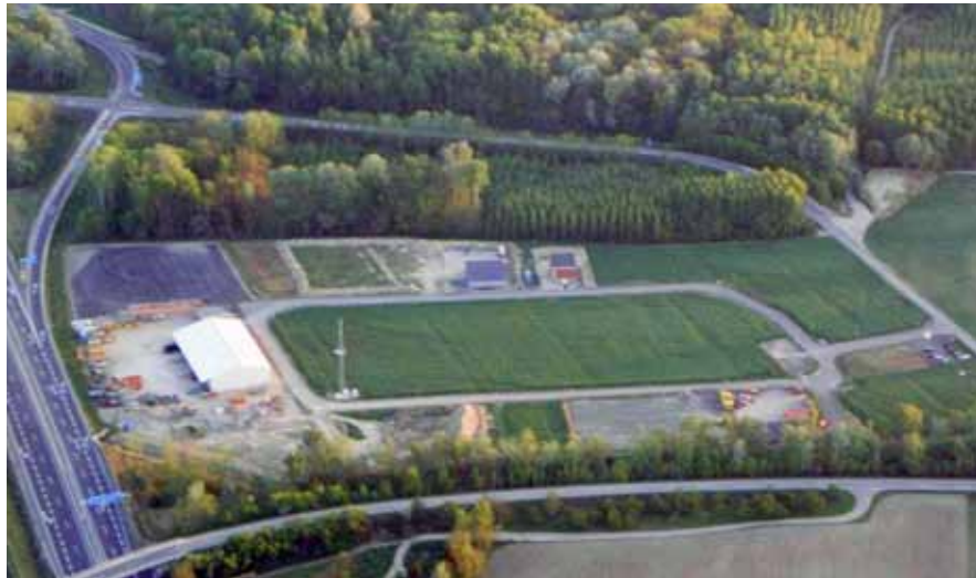
Der Bauteil A des Campus 33 aus der Luft: Betriebsentwicklungen haben bereits begonnen.
