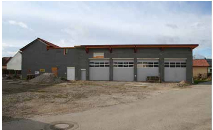
Neubau Feuerwehrhaus Stollhofen.
