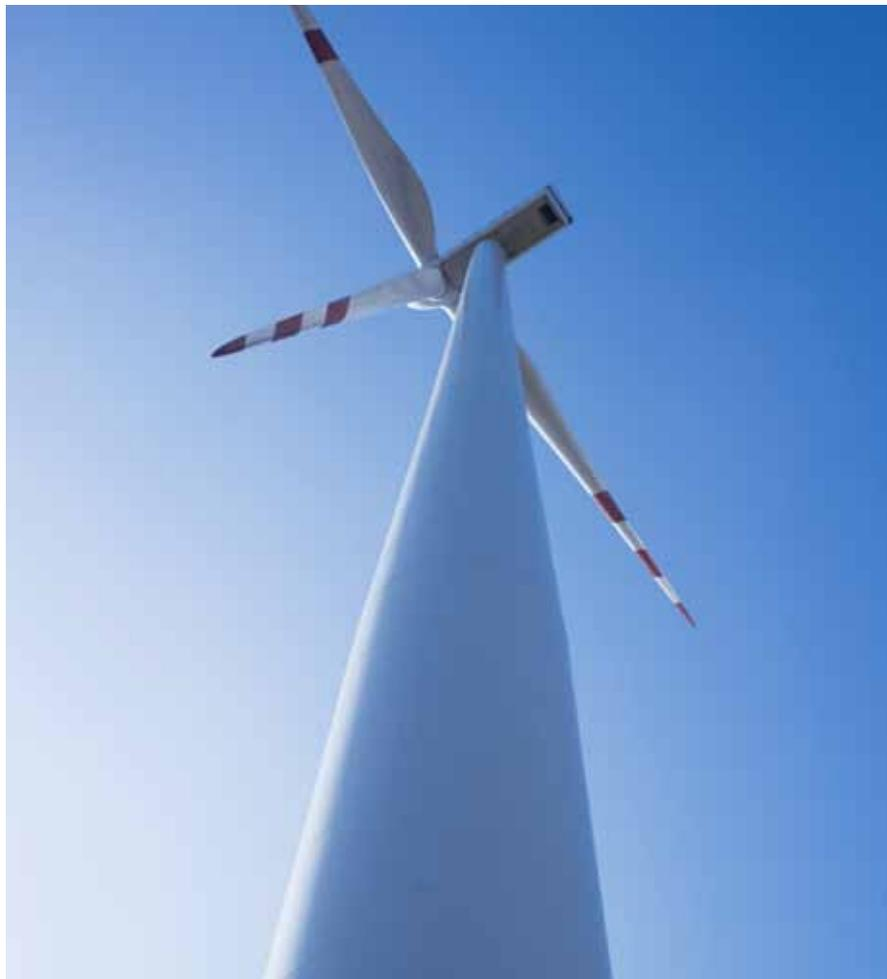
Moderne Windräder der 3 MW-Klasse - davon wird in Trismauer gesprochen - haben eine Nabenhöhe (Rotormitte) von 150 m. Dazu kommt eine Rotorlänge von gut 55 m.
